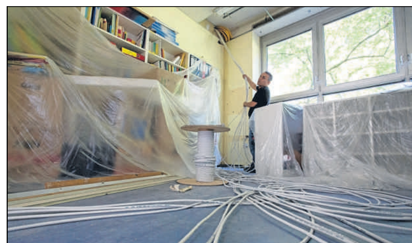
Elektroinstallationen: In der Bornheimer Johann-Wallraf-Schule ziehen die Handwerker Kabel ein.
